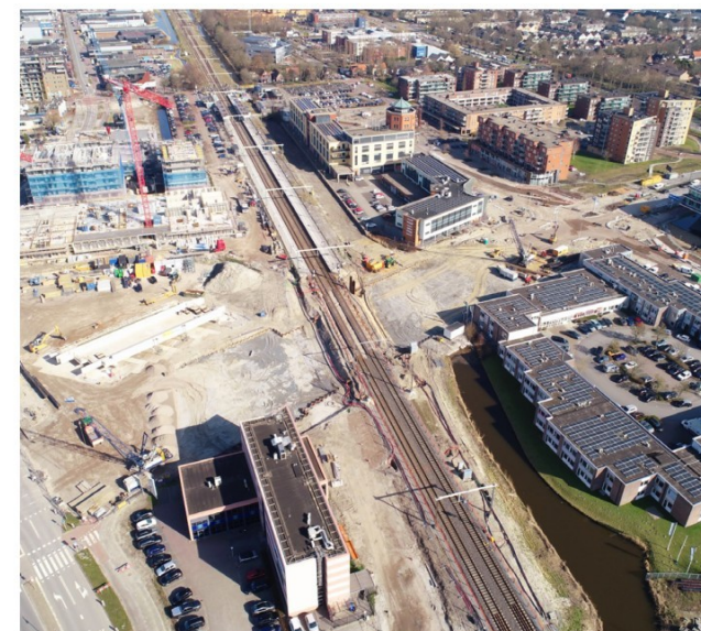
Nieuwbouw bij station Heerhugowaard
