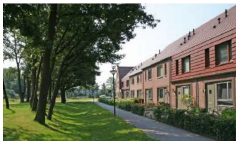
Rijwoningen met verschillende goothoogten
