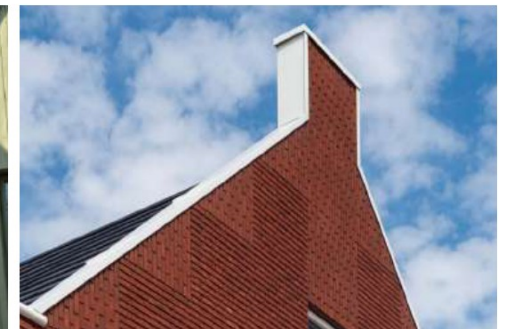
Verbijzondering in het metselwerk
