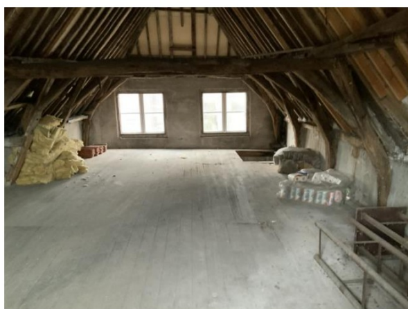
Zolder en dakconstructie is van hout
