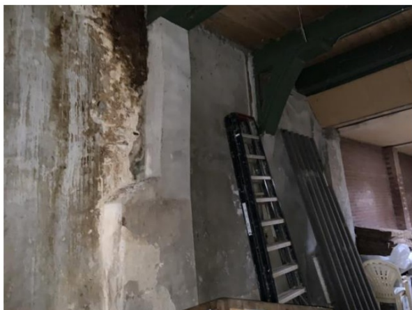
Muren en schoorsteen zijn van steen
