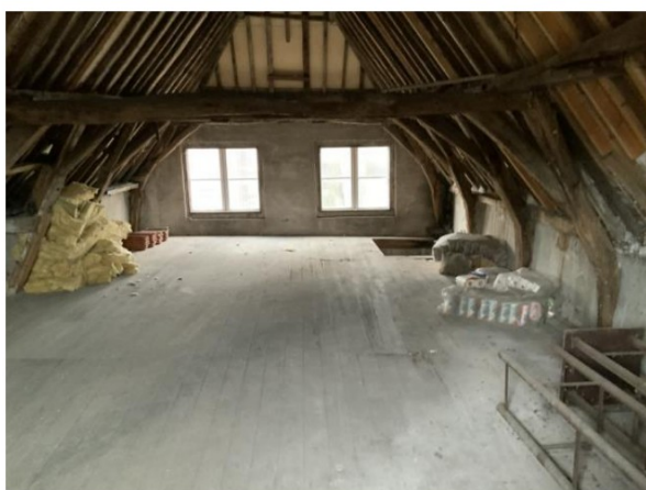
Zolder en dakconstructie is van hout
