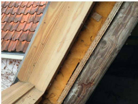
Dak beschot geïsoleerde dakplaat en met dakpannen gedekt
