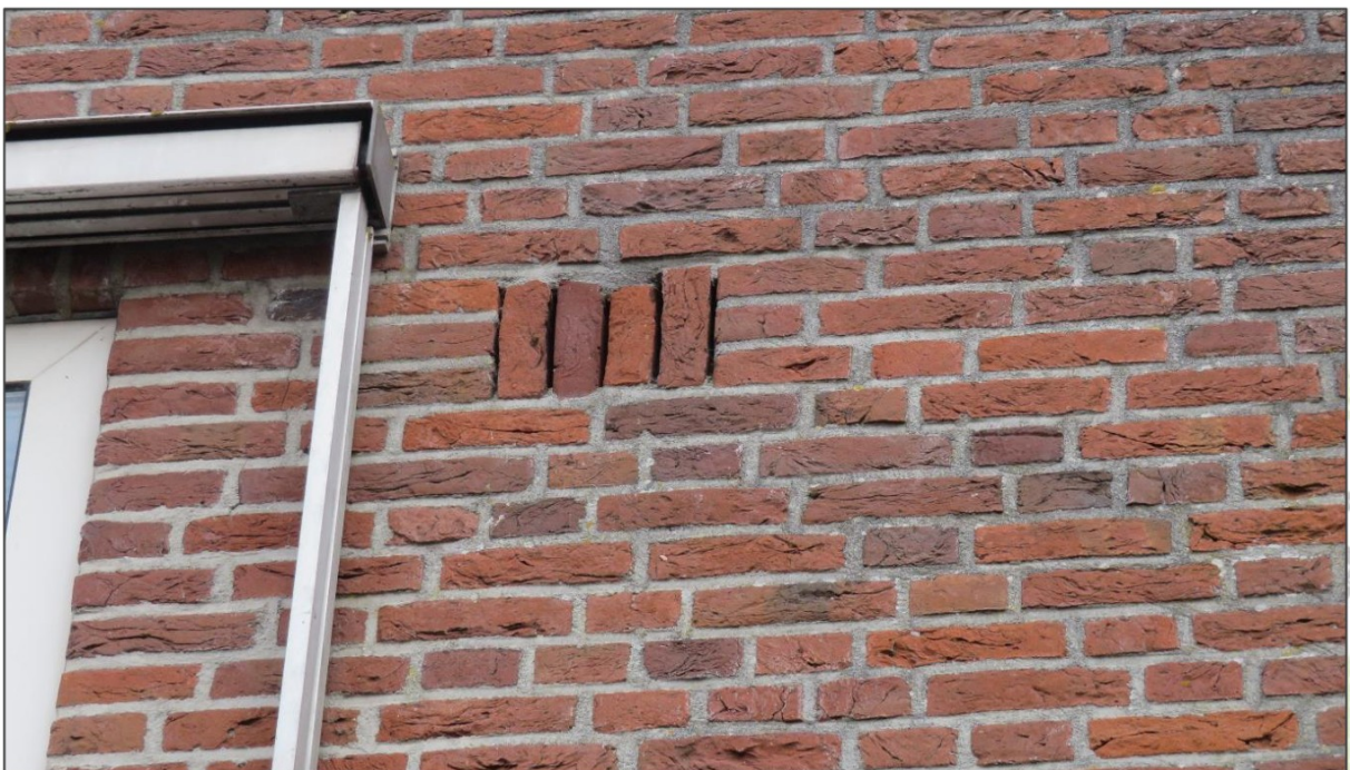
Afb 14: Ventilatieopening geschikt voor vleermuizen
