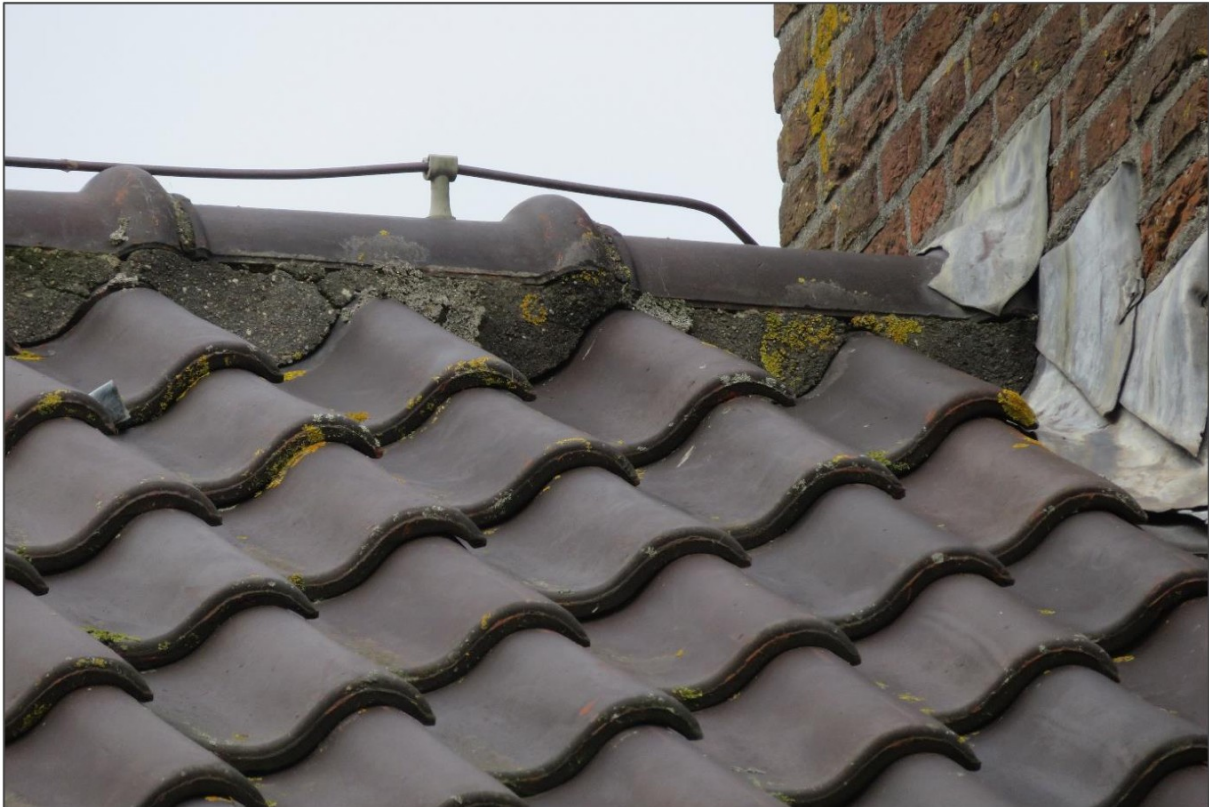
Afb 12: In het dakvlak zelf liggen de pannen strak, zonder scheefstand en schade. Nokvorsten zijn afgesmeerd. Aansluitingen bij schoorsteen dicht
