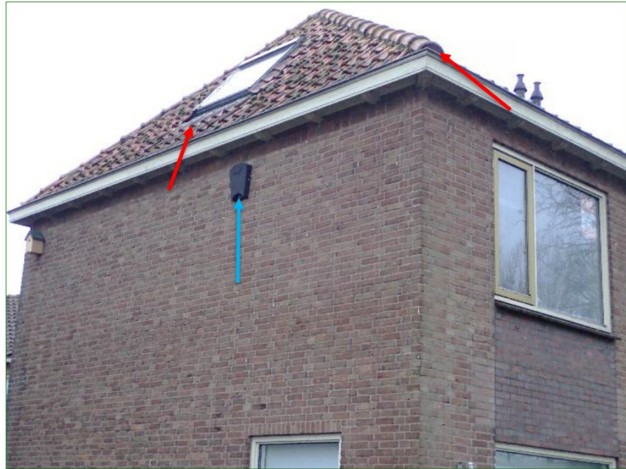
De openingen in de bebouwing (rode pijlen) geven mogelijk toegang tot voor vleermuizen geschikte achterliggende ruimtes. Tevens kunnen de vleermuiskasten (blauwe pijl) in gebruik zijn als verblijfplaats voor vleermuizen.
