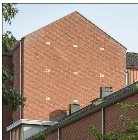
Afb 9 + 10: Gierzwaluwkasten ingemetseld (worden ook gebruikt door Huismussen)
