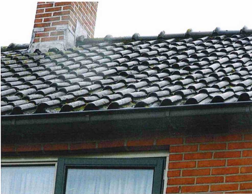
Afbeelding 3. Voor vleermuizen geschikte daken, omdat de dakpannen niet strak aanliggen.
