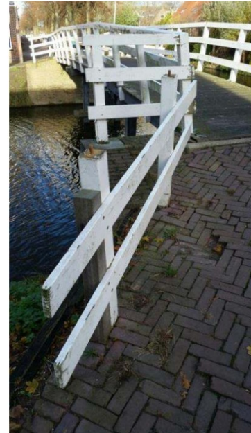
Figuur 18: vervangen houten onderdelen vereist, hier bovenste regel brugleuning "verdwenen"
