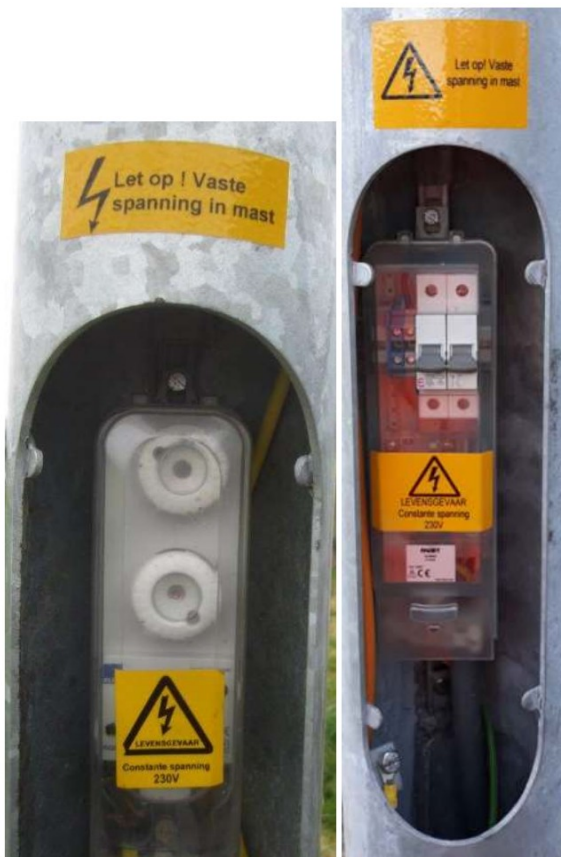
afb. stickers vaste spanning in de mast
